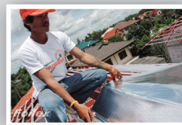
3 จัดวางตามหน้ากว้างและความยาวซึ่งให้ตึง
